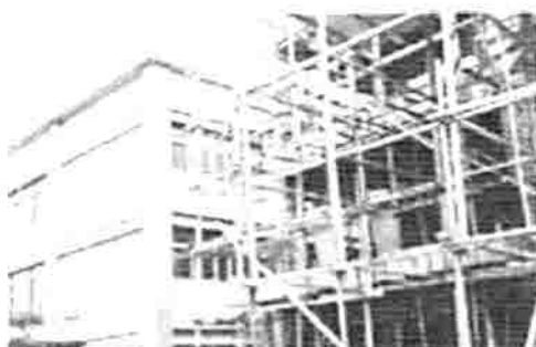
第2研修会館建設状況 (向う側が既設の研修会館)
